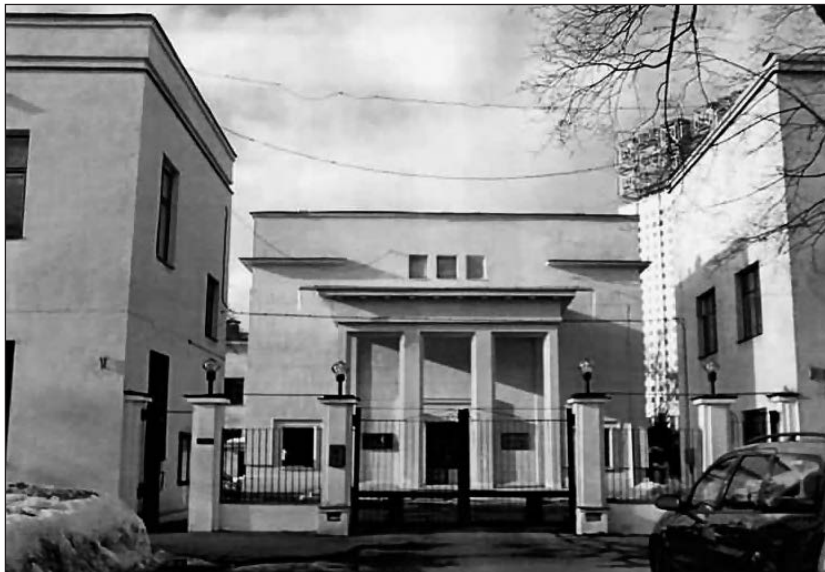
Институт физических проблем: вид с высоты птичьего полета и главный вход.
